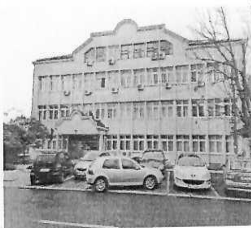
Slika 26 – Lokacija za sirenu S1 – Centar – zgrada Katastra i Suda
