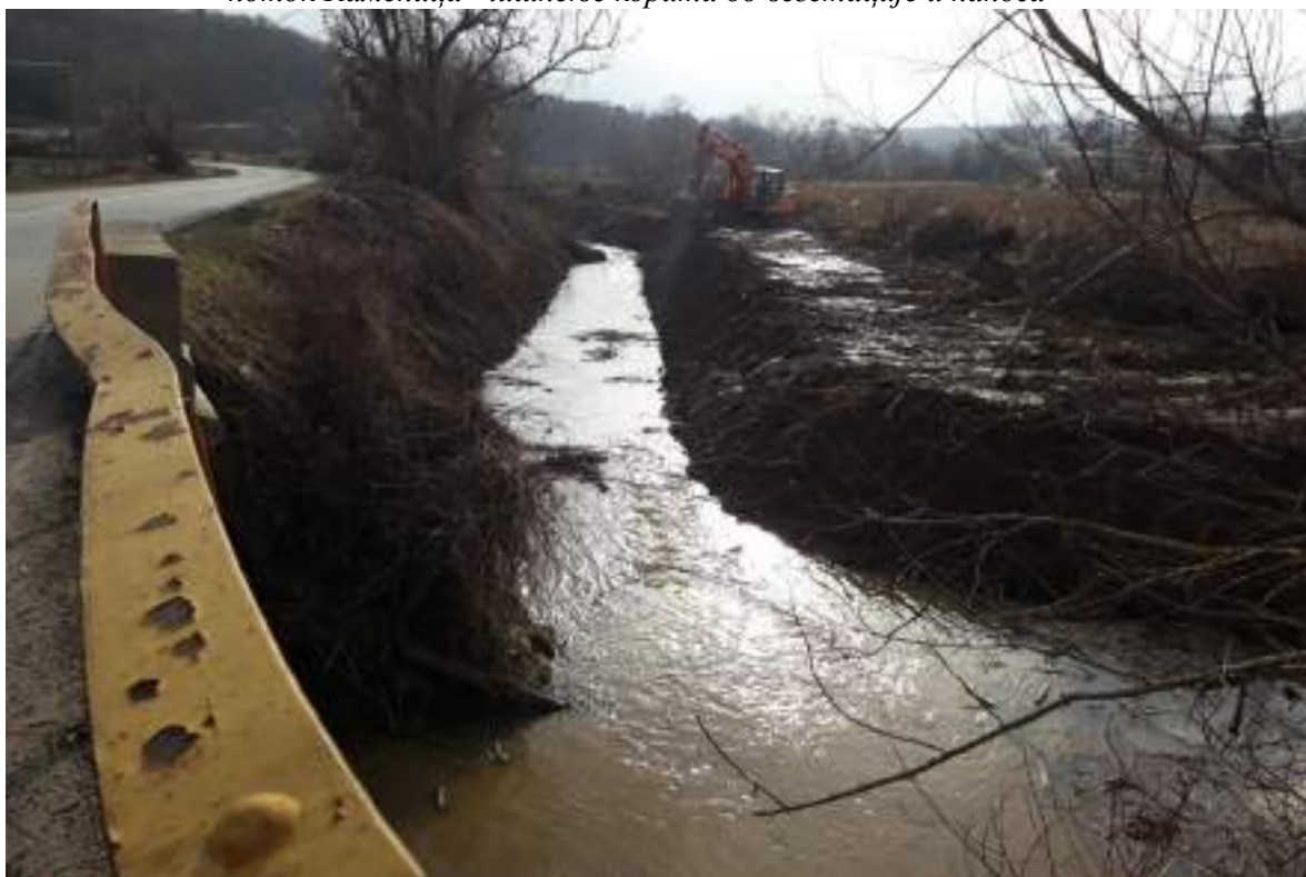
поток Каменица- чишћење корита од вегетације и наноса
