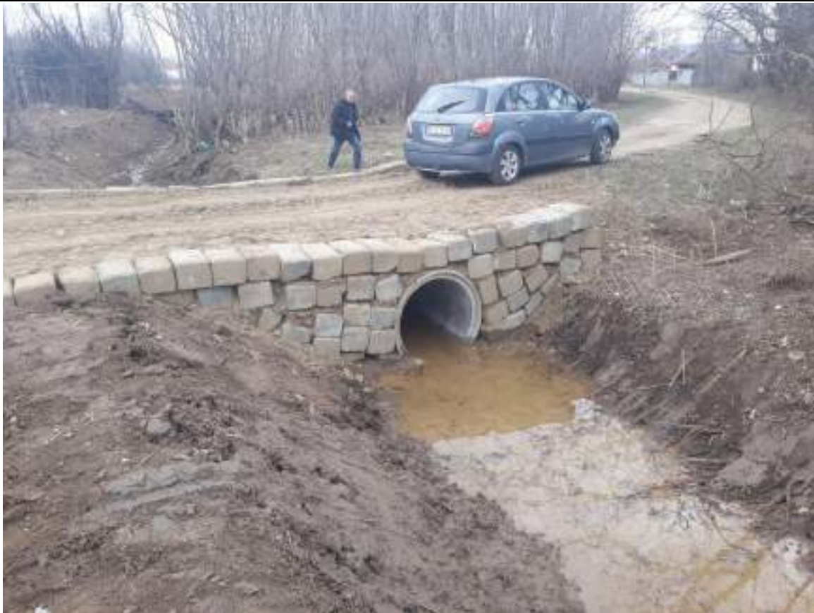
Чишћење потока Кустура од муља и вегетације и изградња цевастог пропуста
