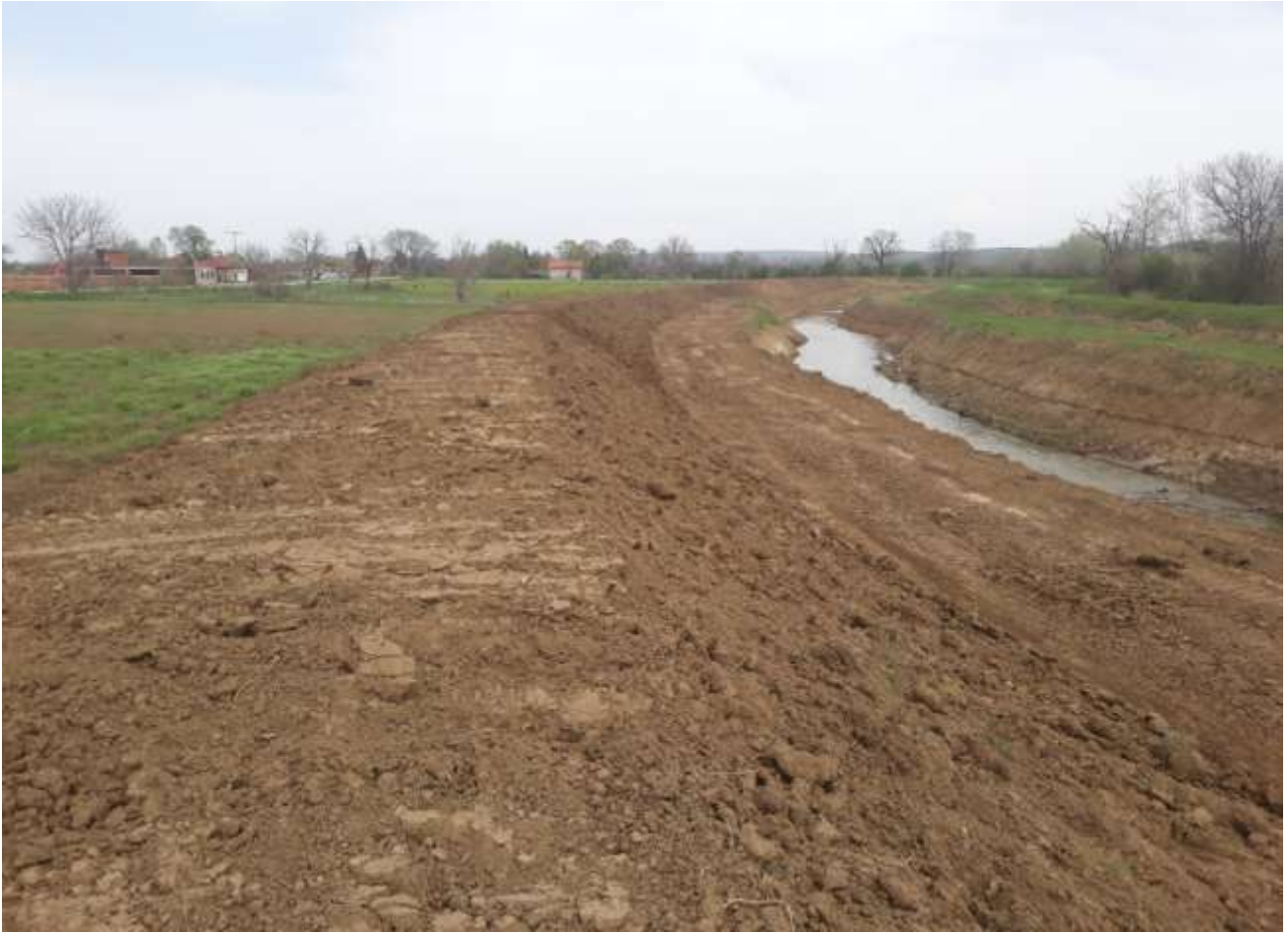
Надвишење левообалног насипа и чишћење корита на реци Јасеници кроз Наталинце
