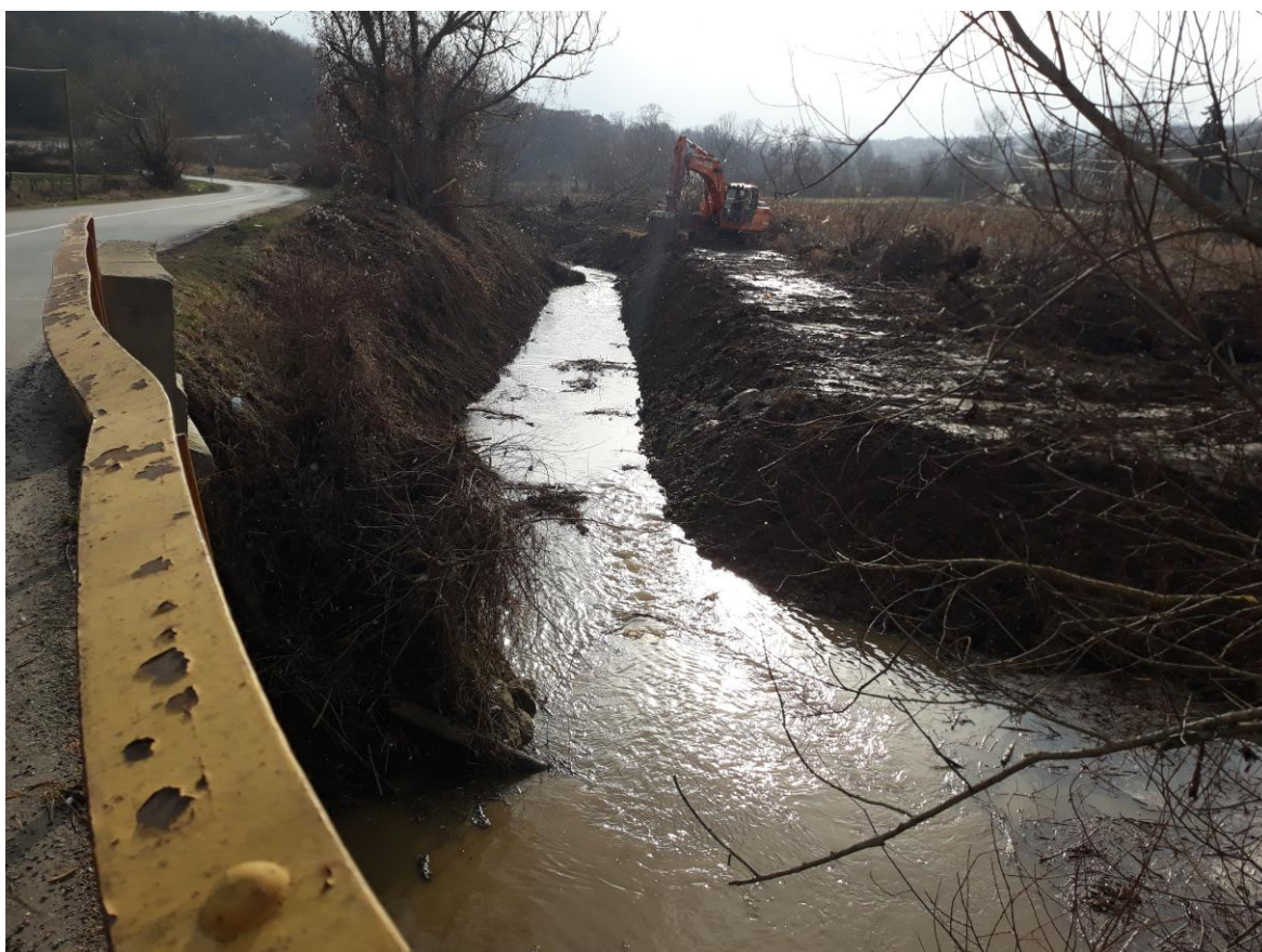
поток Каменица- чишћење корита од вегетације и наноса
