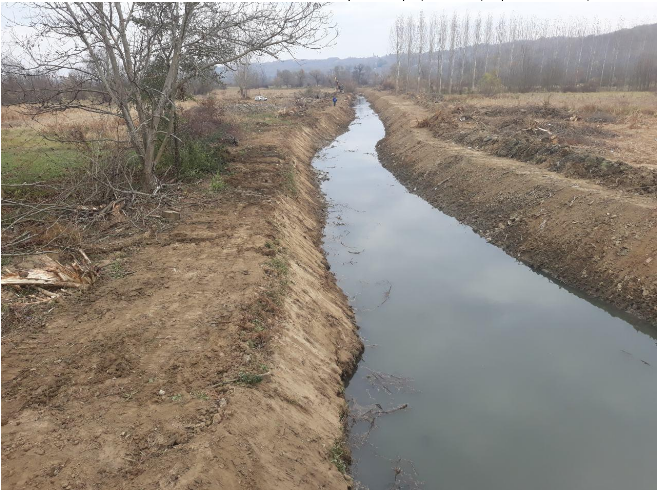
Чишћење корита реке Кубришнице кроз МЗ Загорица
