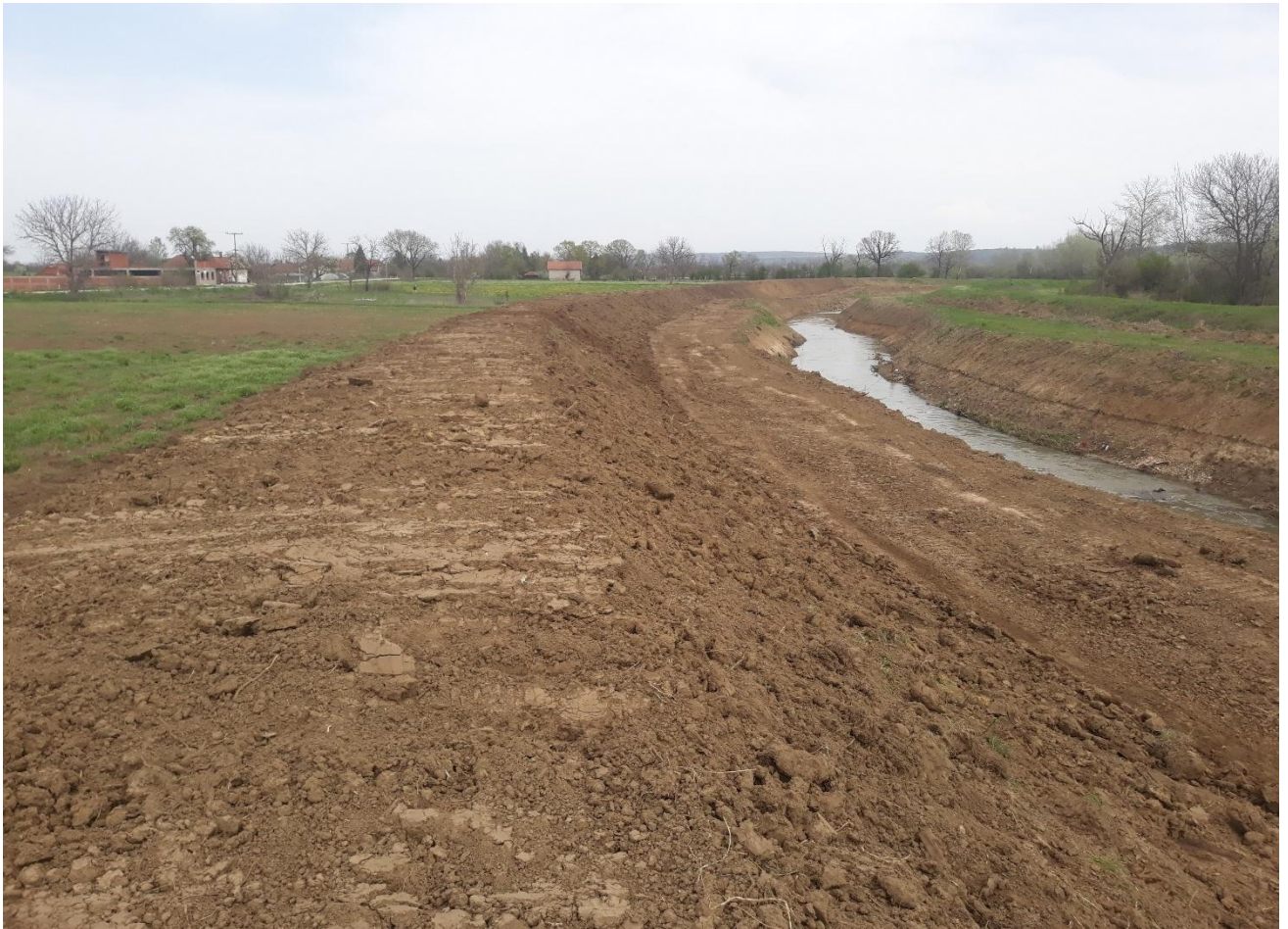
Надвишење левообалног насипа и чишћење корита на реци Јасеници кроз Наталинце
